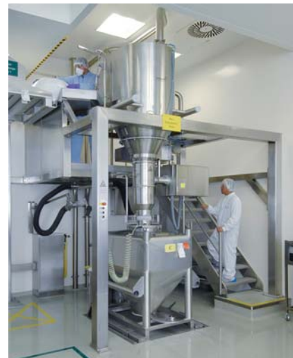
Installation de concassage/broyage, dosage et conditionnement en IBC
